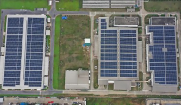
Proterial Vietnam Co., Ltd.の太陽光発電設備
