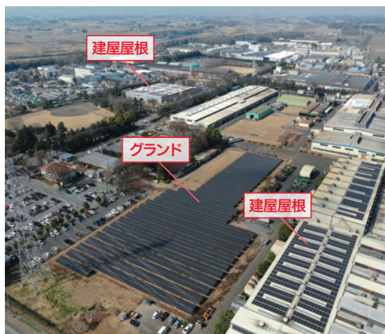
真岡地区太陽光発電設置全景
