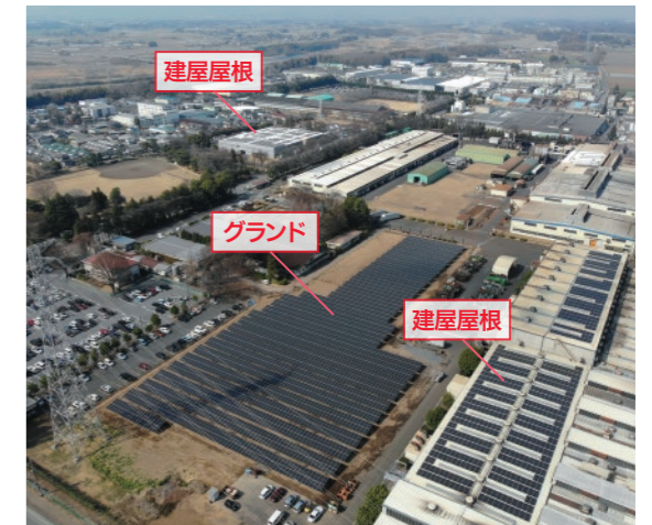
真岡地区太陽光発電設置全景
