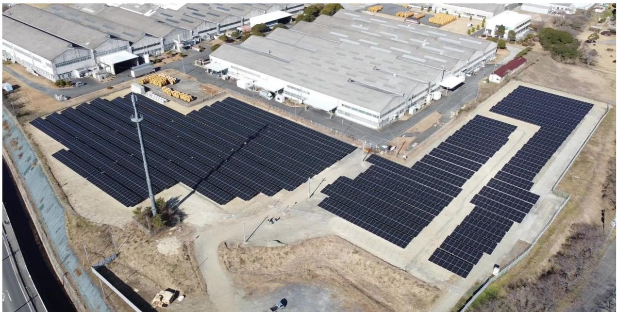
写真：豊浦分工場に導入された自家消費型太陽光発電設備
