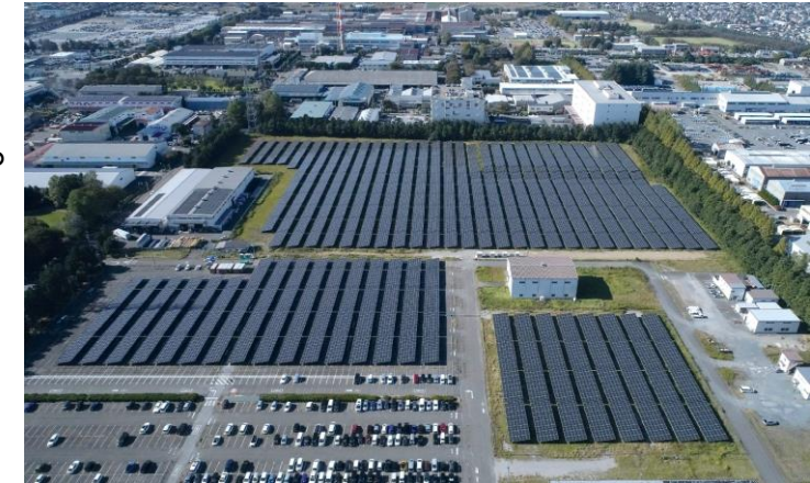
国内最大級の自家消費型太陽光発電設備 （熊谷地区）
