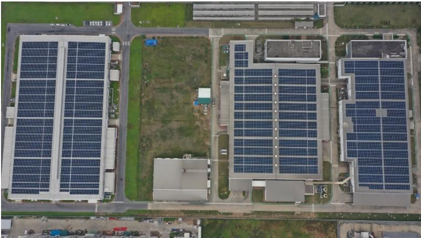
太陽光発電設備全景 (プロテリアル・ベトナム)
