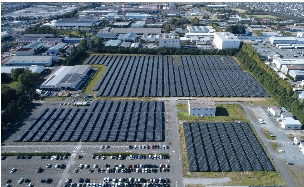
写真：熊谷地区に導入された国内最大級の自家消費型太陽光発電設備
