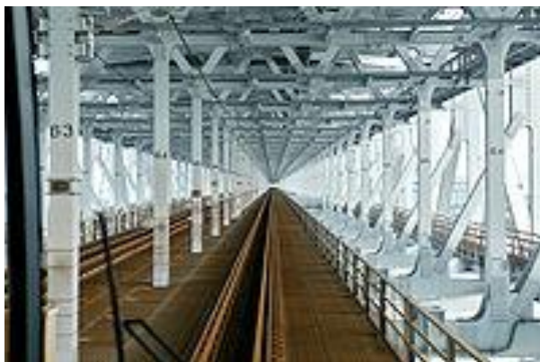
瀬戸大橋線・瀬戸大橋橋梁区間
