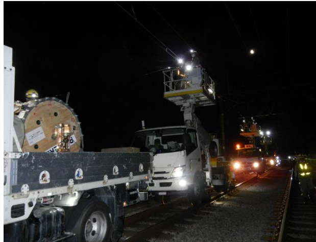
新型トロリ線への張替の様子
