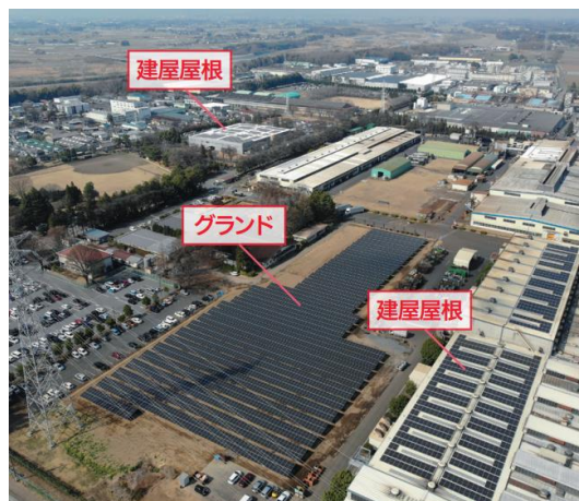
真岡地区太陽光発電設置全景
