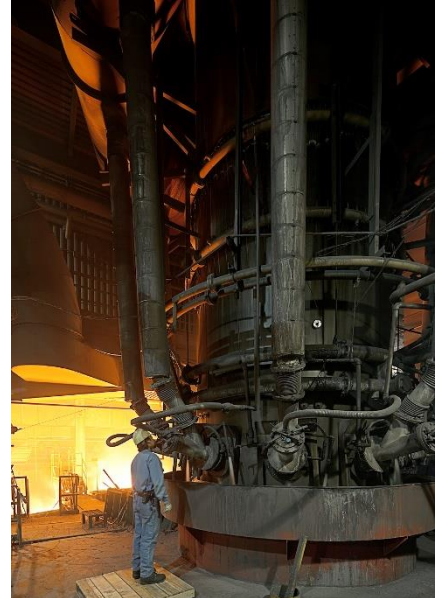
キュポラの燃焼状態の確認
