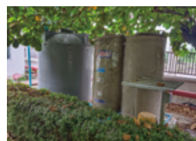
雨水リサイクル水の貯蔵用タンク
