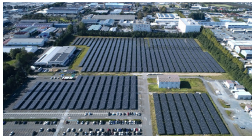
熊谷地区に導入された自家消費型太陽光発電設備
