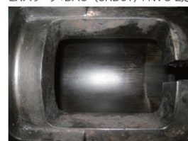
湯口直下の溶損なし
